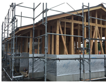
木の温かみのある仮設住宅
